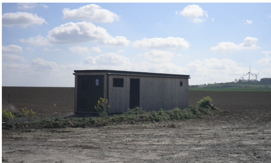
Figure 9 : Exemple du poste de livraison de la vallée de l'Aa (source : VALECO, 2016)
